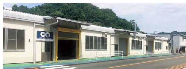
脱硫再生工程(森町工場)
