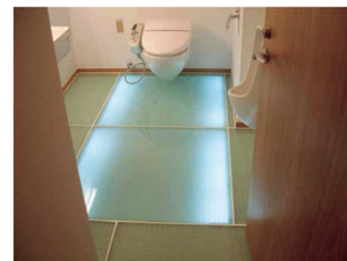
トイレの床下照明
