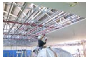
天井の補強工事
