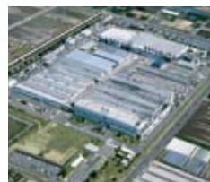
平和町工場 Heiwacho Plant
