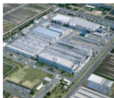
平和町工場 Heiwacho Plant
