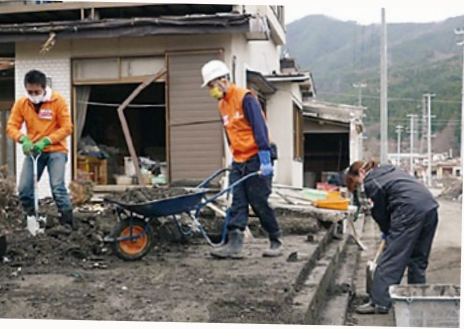
従業員による「汚泥等の除去作業」
