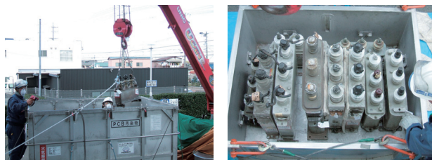
PCBコンデンサーの搬出作業
