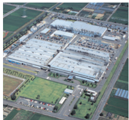
平和町工場 Heiwacho Plant
