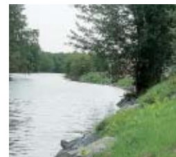
修復されたコーチコック河岸
