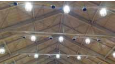
LED高天井照明/森町工場
