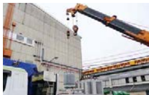
変圧器・電力コンデンサの搬出
