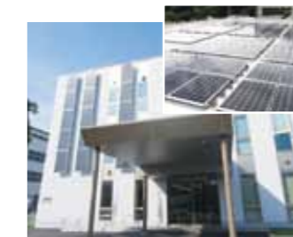
太陽光パネル/森町工場
