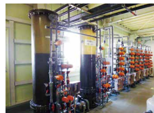
排水処理設備
