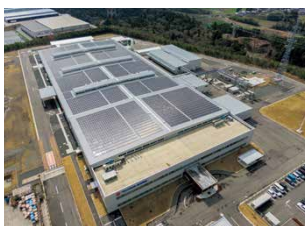
太陽光発電設備
