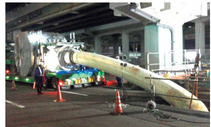
上下水道管の補修技術(芦森工業(株))
