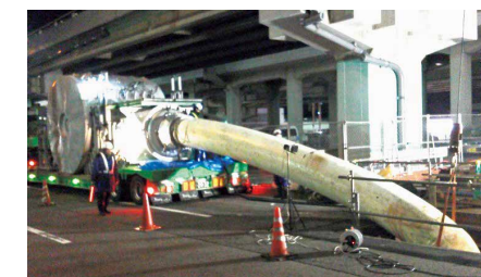
上下水道管の補修技術(芦森工業(株))
