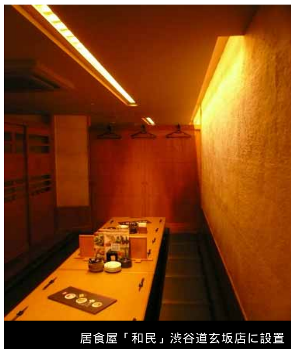
図13 キャンドル色のLED間接照明を壁際とテーブル上の天井内に設置
