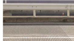
図-3 グルーピング工法が施された路面
