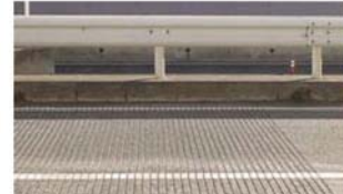
図-3 グルーピング工法が施された路面
